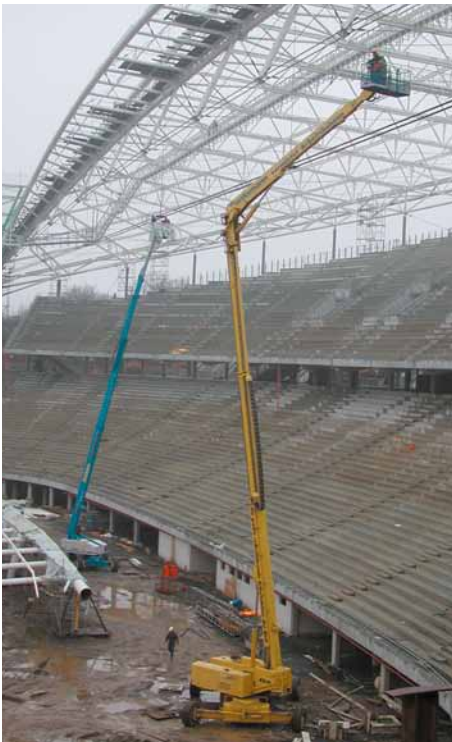
Bild 6-2: Hubarbeitsbühne im Baustelleneinsatz
