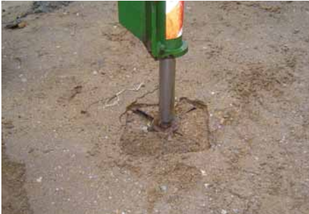
Bild 4-5: mangelhafte Lastverteilung
